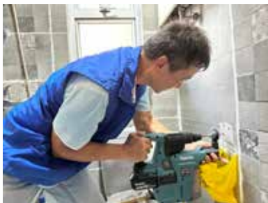
「居有所葺」義工隊目標為超過 1,000 戶基層困難家庭、獨居長者等有需要人士提供防滑扶手安裝，水喉檢查、隔氣清潔等修繕服務。
